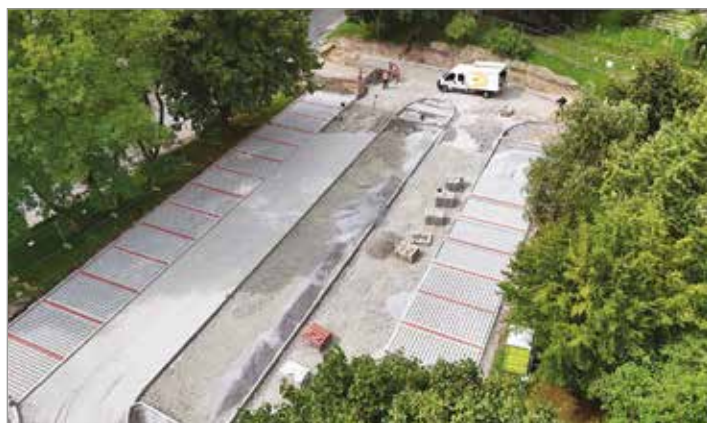
Parkoviště u základní školy – pokládání zatravnovací dlažby
