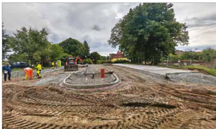
Parkoviště u základní školy – pokládání obrub
