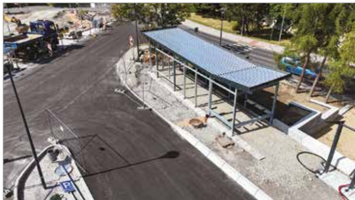
Autobusové nádraží – stavba čekárny
