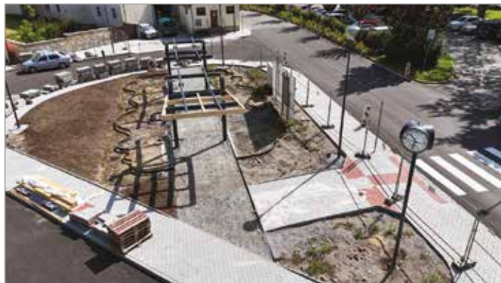
Autobusové nádraží – stavba zastínění v parčíku
